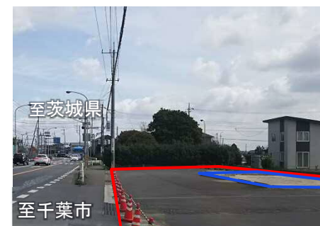
写真②: 用地取得後の状況(H28.4月撮影)
