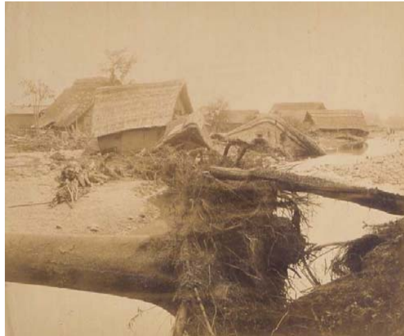
明治29年9月12日台風豪雨による被害状況(甲斐市) 出展:土木学会図書館旧蔵写真館
