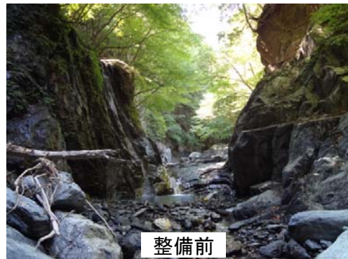
② 黒河内第四砂防堰堤(平成26年竣工)
