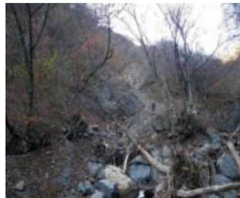
堰堤配置付近の崩壊状況
