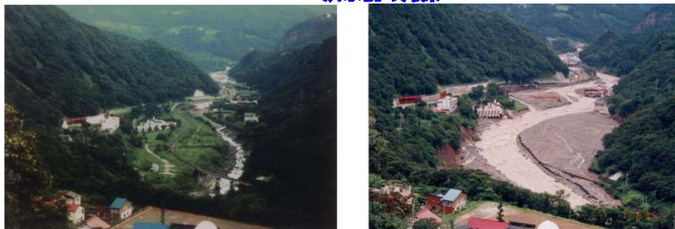
洪水前(左)・後(右)における河床上昇の事例(姫川水系河川整備基本方針より抜粋)
