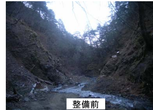
③ 湯川第三砂防堰堤(平成27年竣工)
