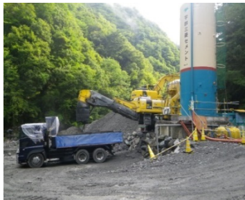
現地発生材料混合状況
