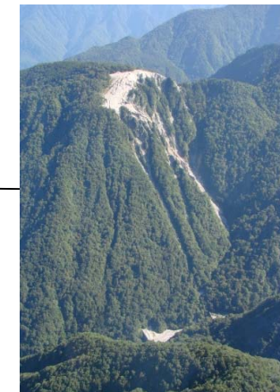
ひなたやま 日向山周辺の 荒廃状況
