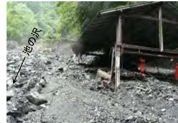
平成23年9月の災害状況(索道)
