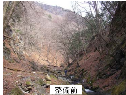
① 黒川第四砂防堰堤(平成25年竣工)
