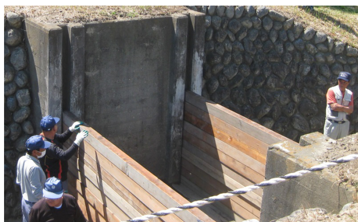
ゲートを閉める訓練中の大麻生陸閘
