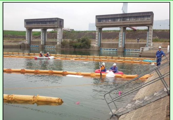
※オイルフェンスを張り終わり、オイルマットを布設中。
