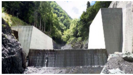
完成 (一期工事)
