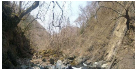
着工前 (一期工事範囲)
