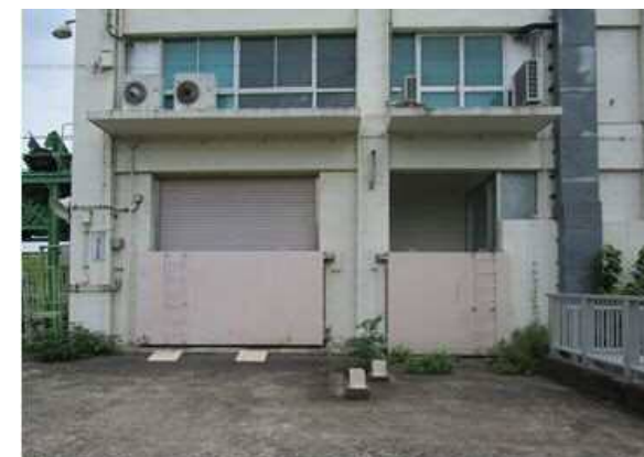
入口にはゲートを設置
