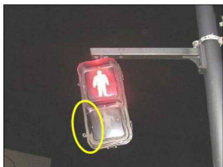
信号機の傾斜状況とひさし変形状況
