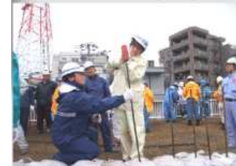
↑ 「積み土のう工」の習得
