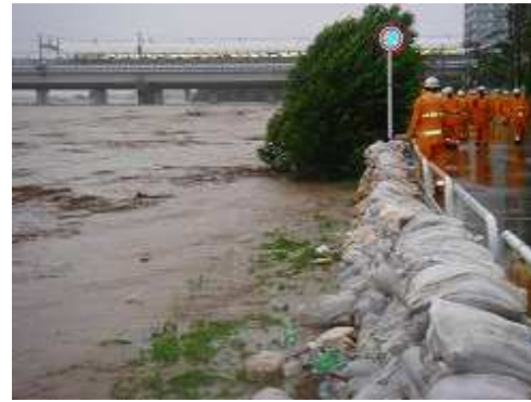
水防活動(土のう積み)
