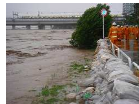
水防活動(土のう積み)
