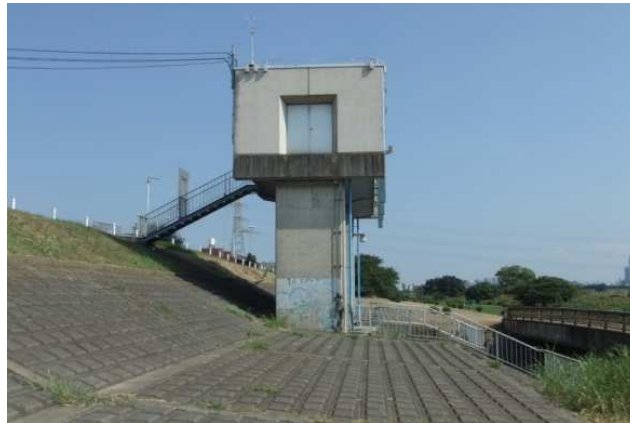
玉川排水樋管
