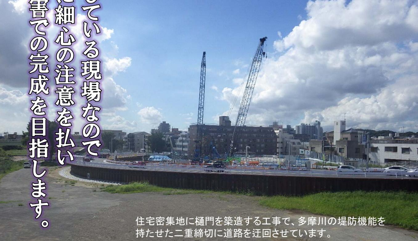
住宅密集地に樋門を築造する工事で、多摩川の堤防機能を持たせた二重締切に道路を迂回させています。
