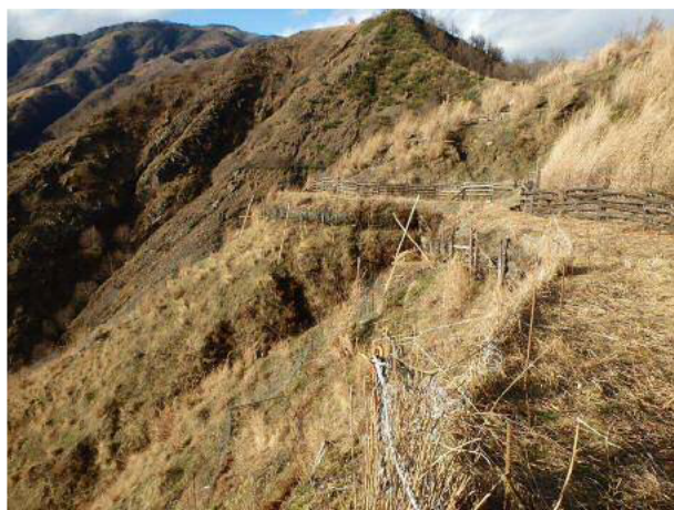
Aライン補修前
