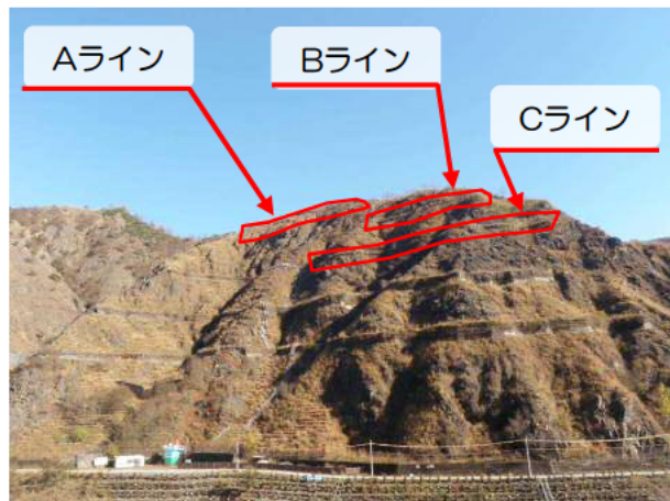
松本山腹工全景（着工前） 全5段の山腹工があり、今回は 上3段を施工
