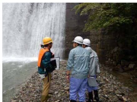
砂防施設点検
