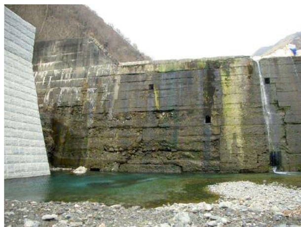
堤体補強施工前
