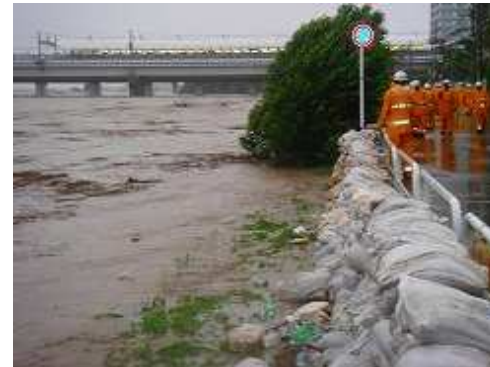
水防活動（土のう積み）
