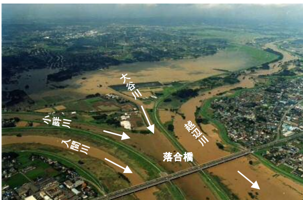
入間川、小畔川、越辺川合流点付近
