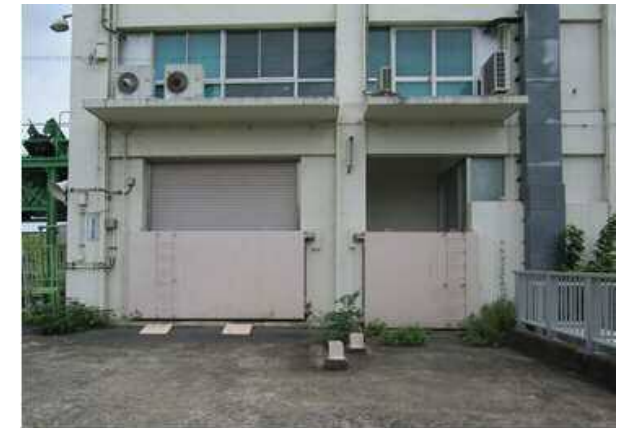
入口にはゲートを設置
