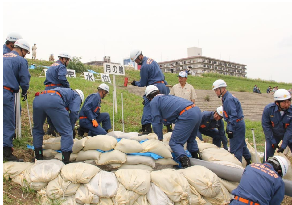
三郷市水防訓練：水防工法 月の輪
