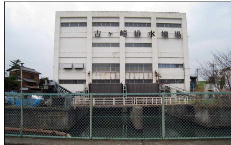
古ヶ崎排水機場
