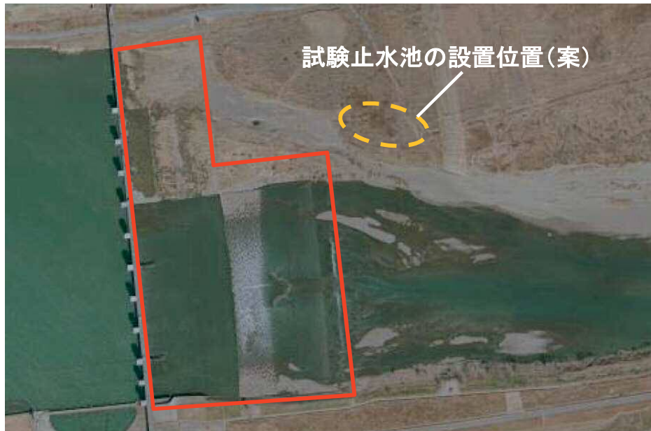
利根大堰施設管理範囲(赤枠部)
