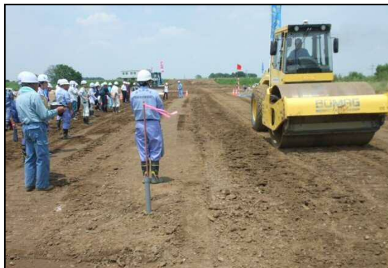
締め固め管理の説明状況
