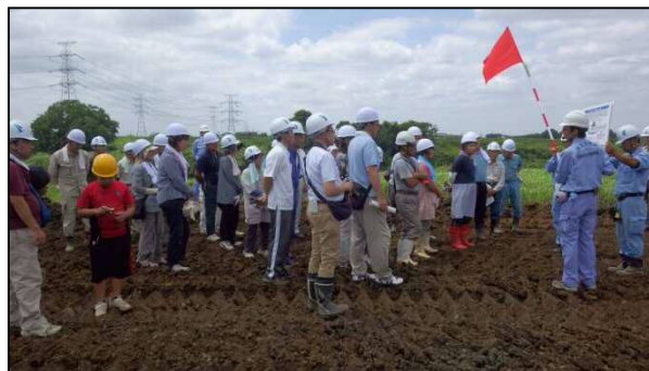
盛土の施工状況説明
