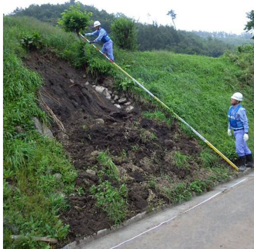
岩泉町 被災状況調査
