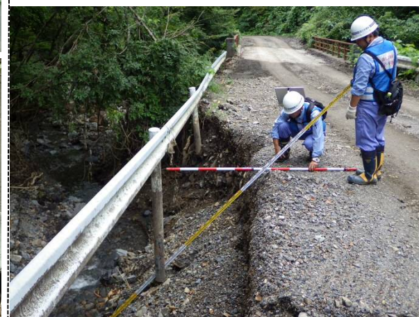
久慈市 被災状況調査
