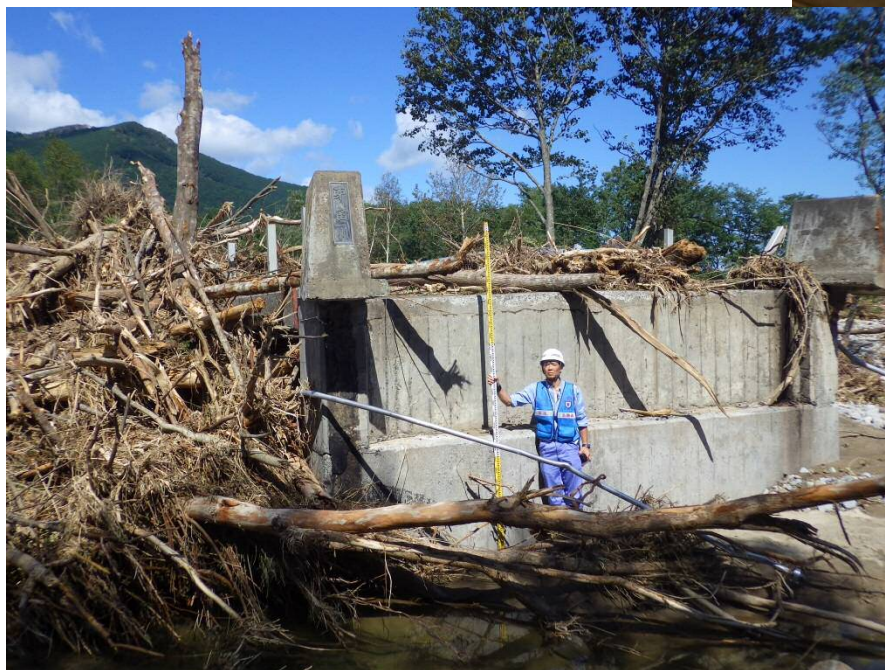
清水町 被災状況調査(橋梁流出)
