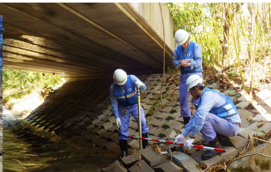
清水町 被災状況調査(橋梁護岸損傷)
