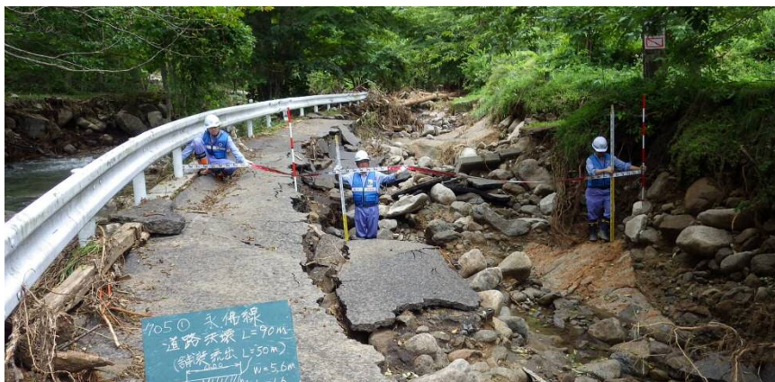
岩泉町 被災状況調査(道路損壊)
