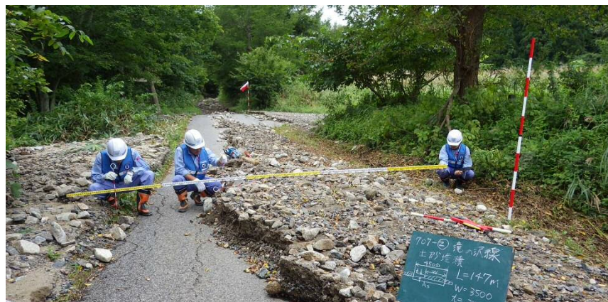
岩泉町 被災状況調査(流出土砂堆積)
