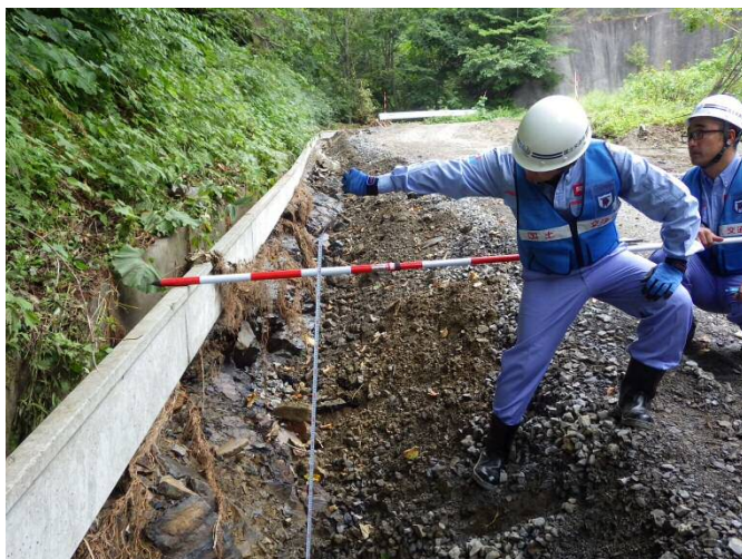
岩泉町 猿沢地区・上有芸地区 被害調査
