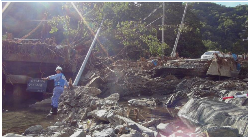
久慈市 田面木橋 被害調査
