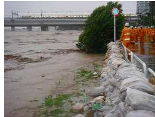
水防活動(土のう積み)
