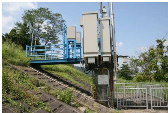
草花排水樋管
