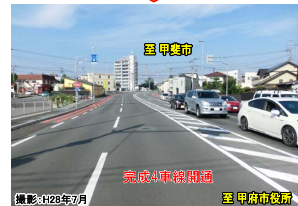
平成28年度の状況写真
