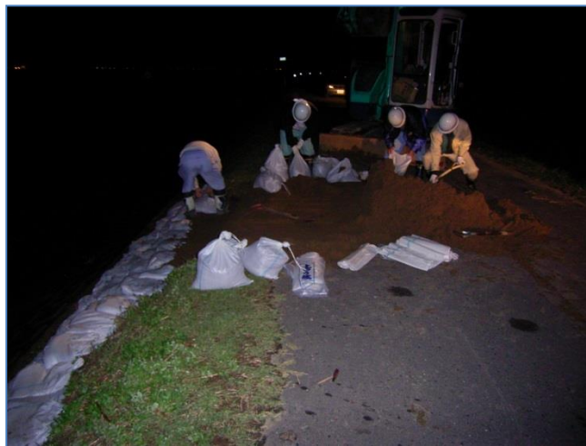
建設業者による水防支援
