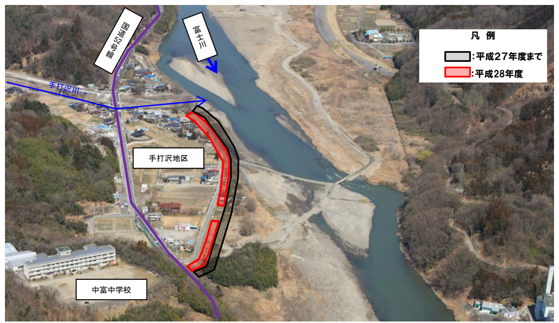
手打沢地区堤防整備
