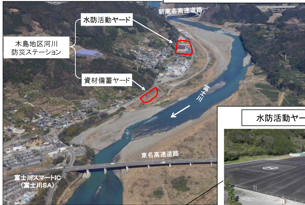
■ 木島地区河川防災ステーション
