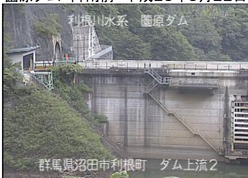
藺原ダム 降雨前 平成28年8月22日 5時撮影
