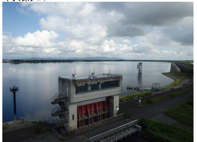
渡良瀬貯水池
