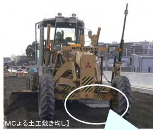
敷均しのラップ部分、材料がほとんど掻き出されないレベルの精度で施工できる
