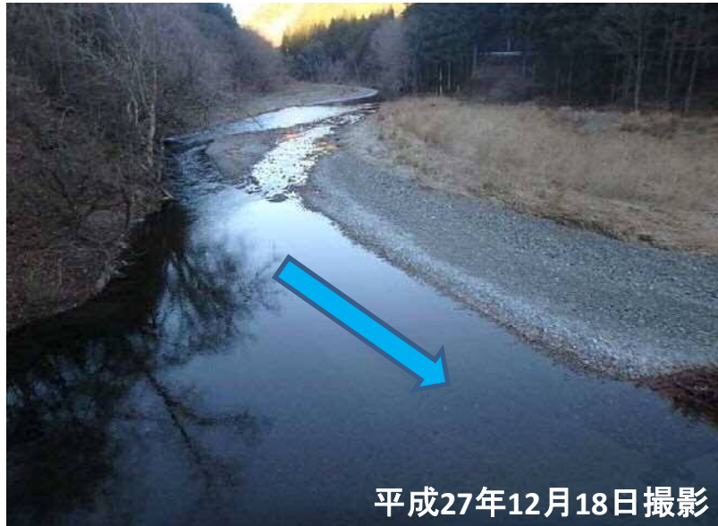
乙母砂防堰堤右岸天端から上流を望む
