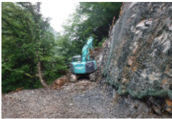
保川工事用道路掘削状況
