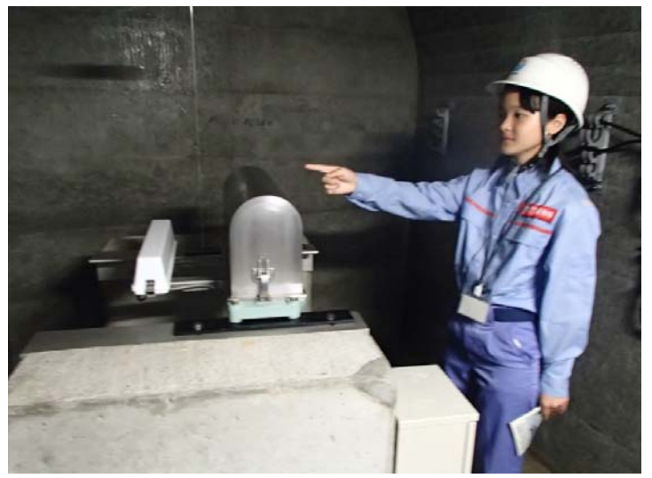
川治ダム堤体内での監視装置(プラムライン)の確認
