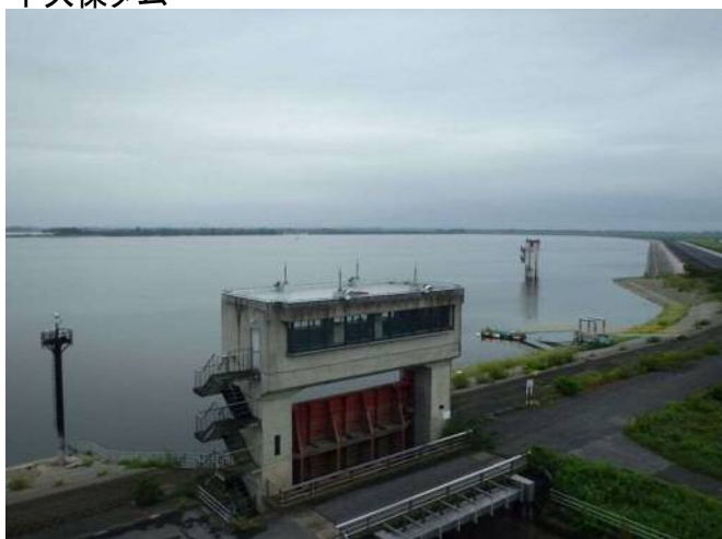
渡良瀬貯水池
