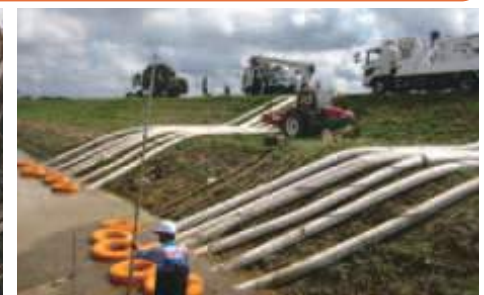
ポンプ車による排水作業 （関東・東北豪雨 2015年9月）
