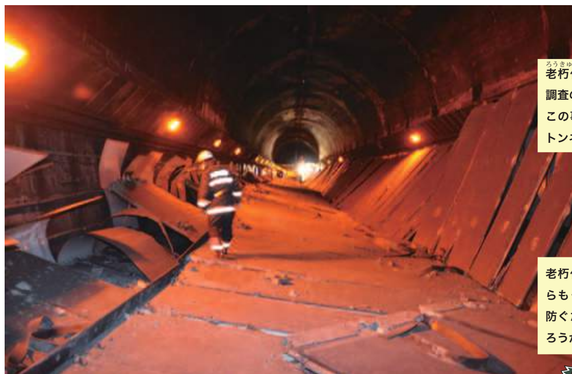
❶ 笹子トンネルの事故現場 2012年12月に中央自動車道の笹子トンネル上り線で天井板が落下し、9人が亡くなる悲惨な事故が起きました。[事故の翌日撮影の写真：山梨県大月市消防本部]
