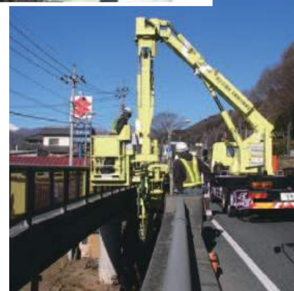
❶ 橋梁点検車による点検 橋に損傷がないかを点検するため、いろんな角度から橋に近づいて確認しています。
