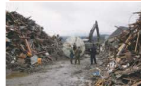
緊急輸送路の確保 （道路啓開・東日本大震災 2011年3月）
