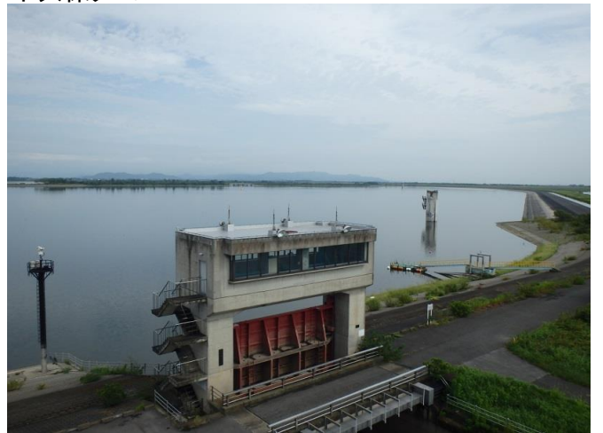
渡良瀬貯水池
