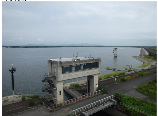
渡良瀬貯水池
