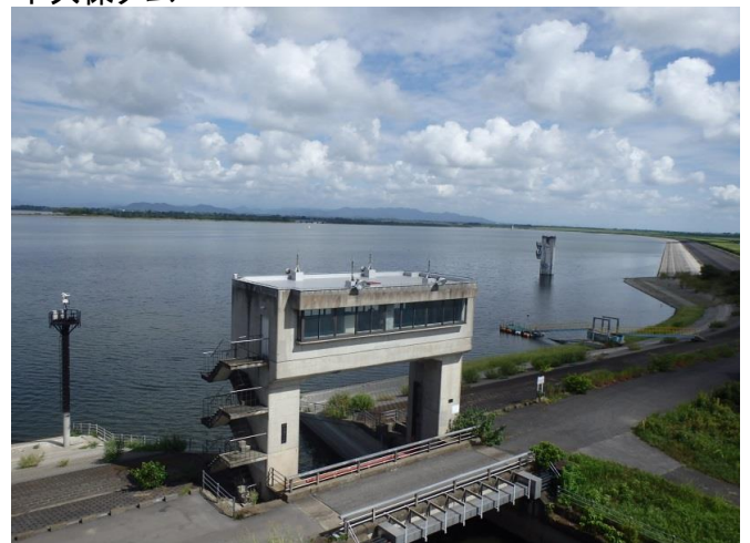
渡良瀬貯水池
