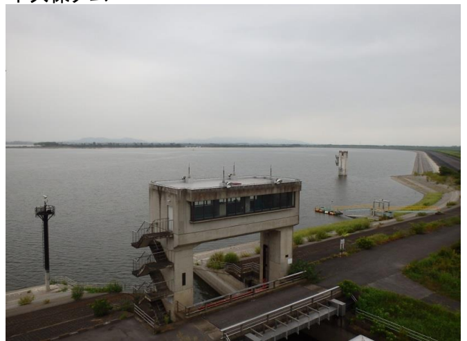
渡良瀬貯水池
