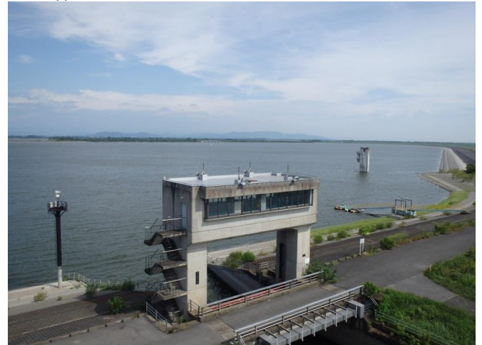
渡良瀬貯水池
