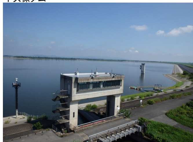
渡良瀬貯水池
