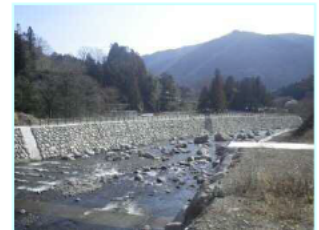
【H27関守左岸護岸他整備工事】
