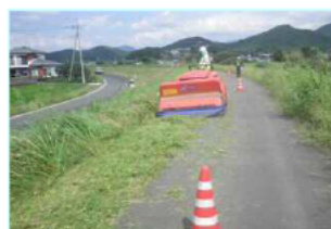
【H27桐生管内維持管理工事】
