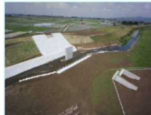
【H26伊保内橋下部工事】
