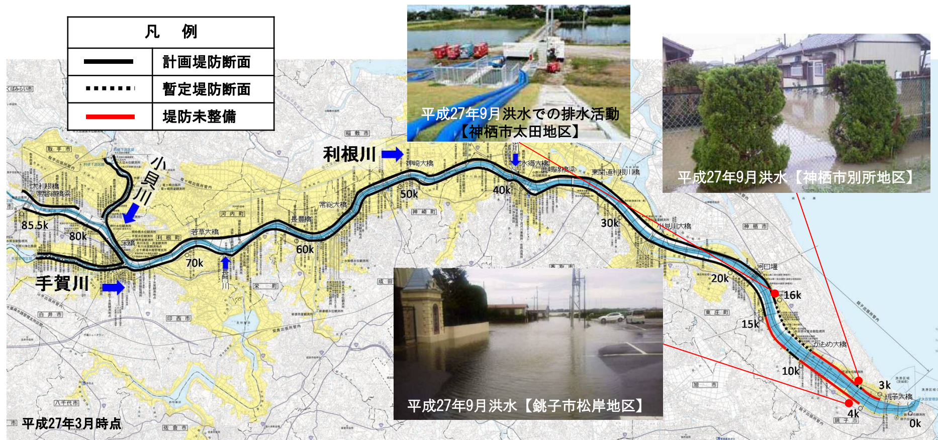
利根川下流域の堤防整備状況図
