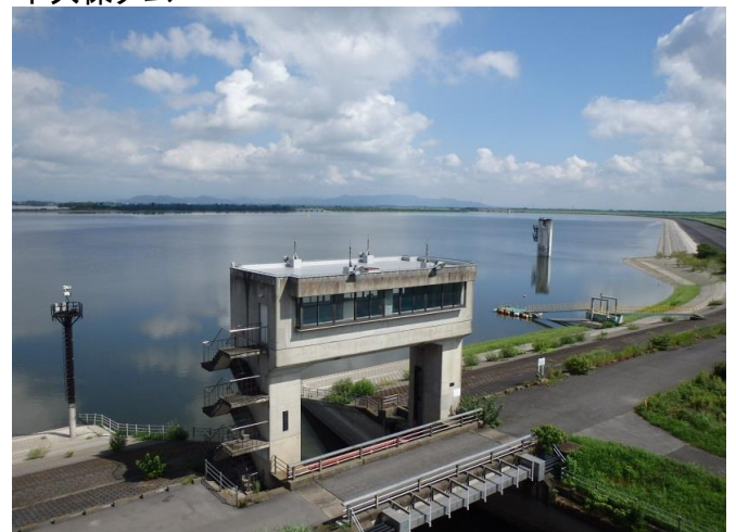
渡良瀬貯水池
