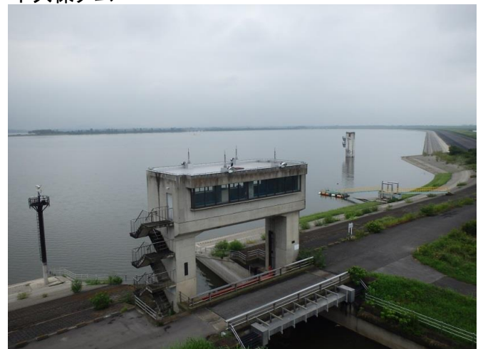
渡良瀬貯水池
