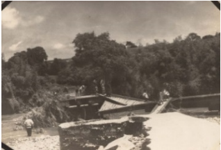
洪水によって破壊された支川 里川の茅根橋(茨城県常陸太田市)
