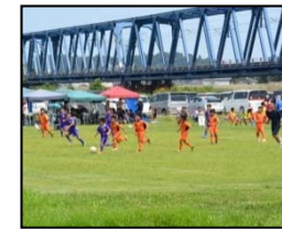
基盤整正(高水敷不陸整正)
