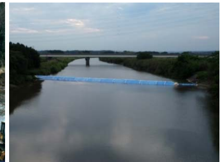
土堰堤(平成28年6月)
