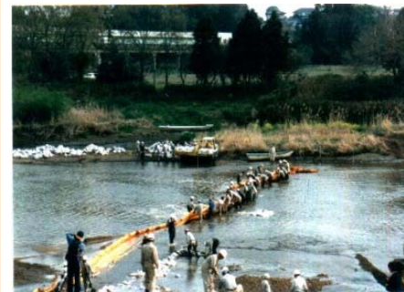
渇水時における防潮フェンス設置の作業状況(平成8年4月)
