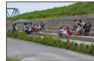
高水護岸(階段護岸)
