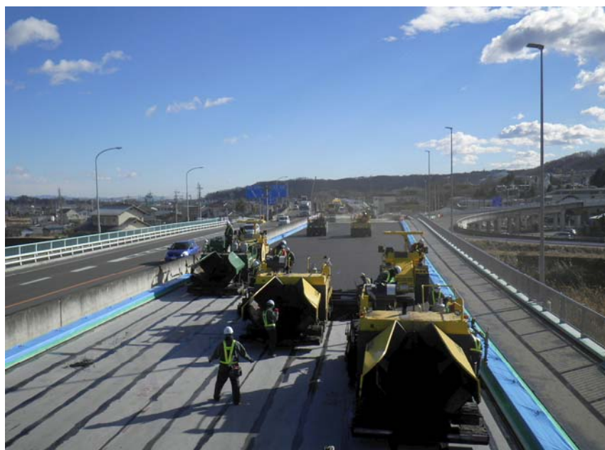
施工状況【新久芳橋 橋面舗装】 (ホットジョイント工法による舗装品質の向上) 長野方面より高崎方面を臨む
