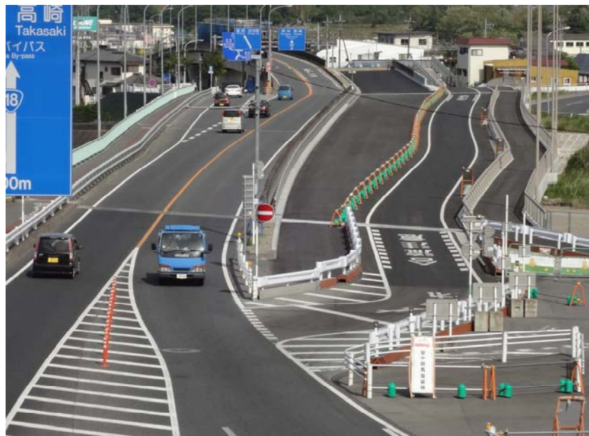
完 成【18号 高崎安中拡幅】 長野方面より高崎方面を臨む (下野尻歩道橋上より撮影)
