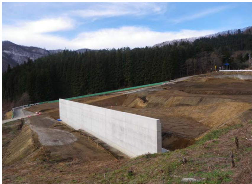
完 成【 全 景 】 起点側より施工箇所全景を臨む
