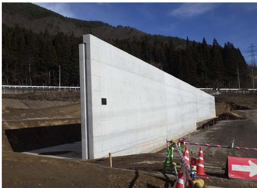
完 成【 場所打ち擁壁 】 終点側より起点側を臨む
