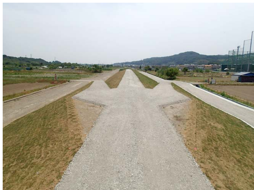
完 成【全 景】 烏川右岸14.3km付近・堤防天端 上流から下流を臨む
