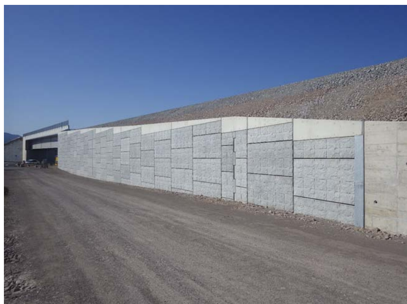
完 成【補強土壁工】
