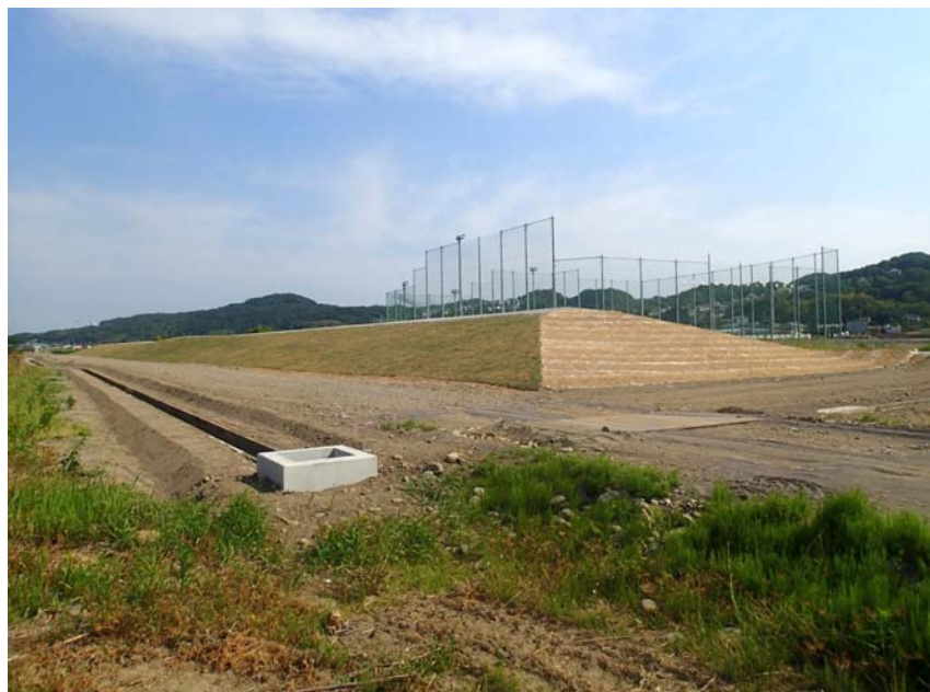
完 成【全 景】 烏川右岸14.3km付近 上流から下流を臨む
