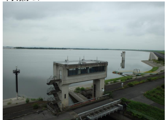
渡良瀬貯水池
