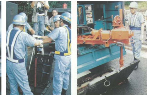
配水バルブの操作状況(東京都)(平成6年)
