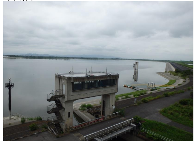
渡良瀬貯水池
