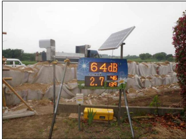
低騒音・低振動型の重機を使用するとともに、騒音・振動を計測監視し、低減に努めています。
