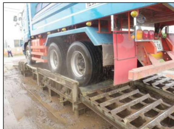
工事現場から出た土砂運搬車両のタイヤに付着した土で周辺道路が汚れないよう、工事現場から出る際には、タイヤを洗浄しています。
