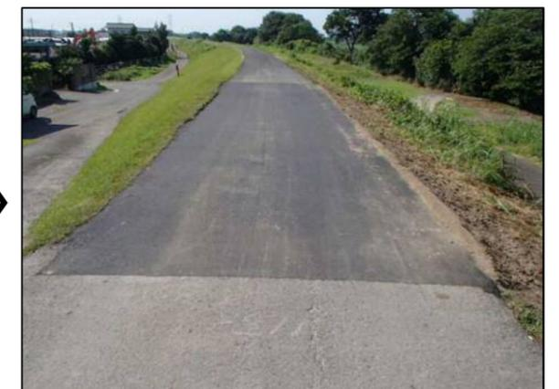
土砂の運搬等により、堤防天端が破損した場合には速やかに復旧作業を行っています。
