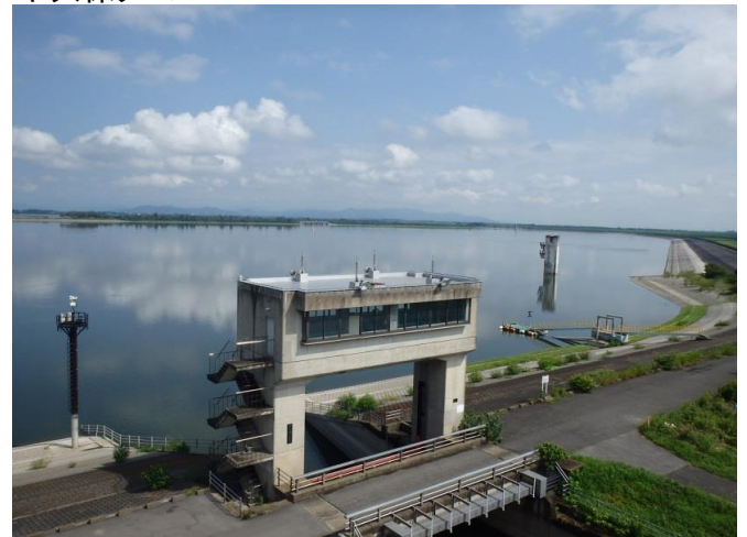
渡良瀬貯水池
