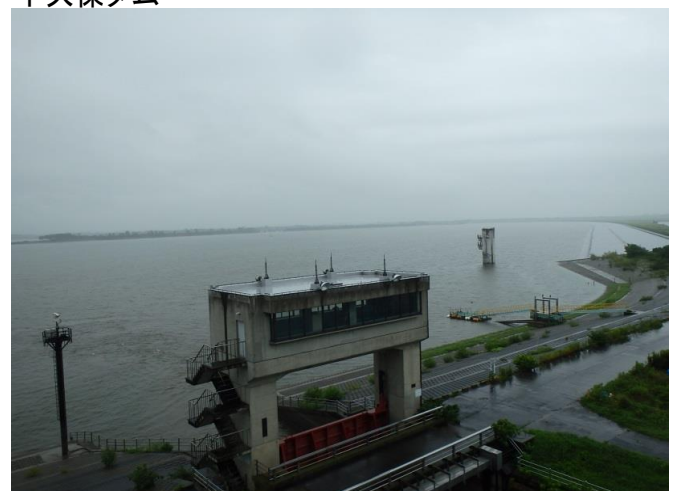
渡良瀬貯水池
